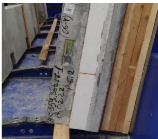
Рис 7. Транспортирование наружных стеновых панелей полуприцепами-панелевозами слегка наклонном положении
