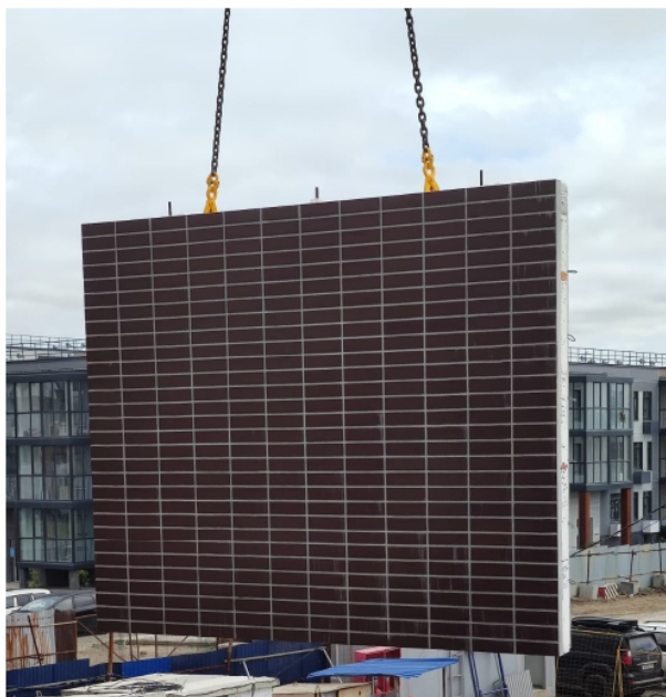
Рис. 8. Стropовка панелей наружных стен.
